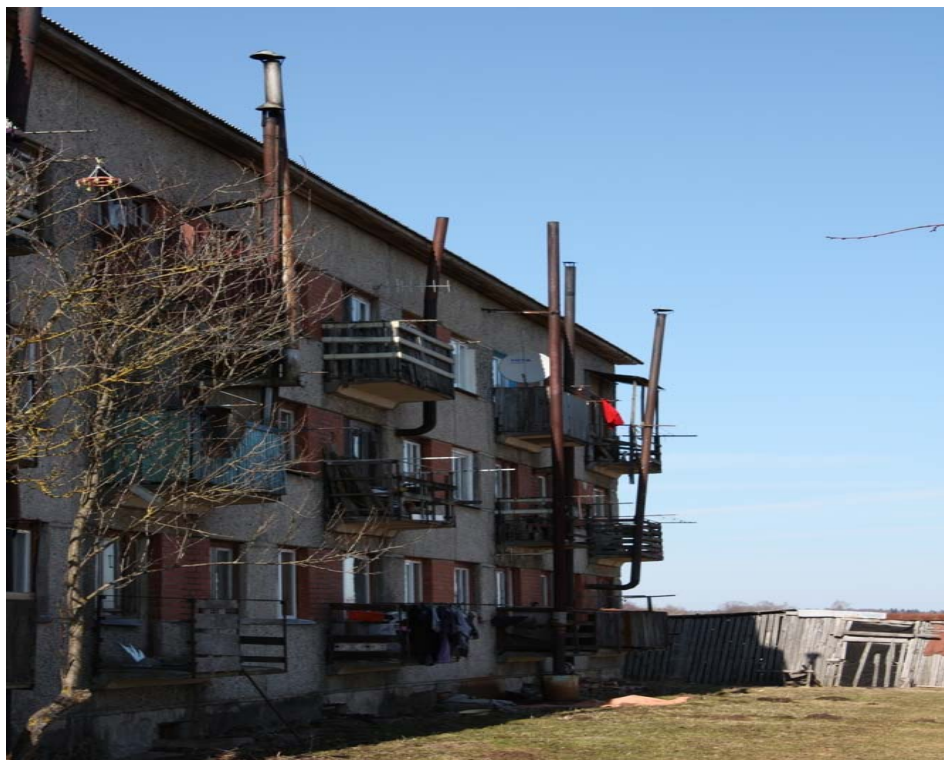
Attēls 3.4. Decentralizētās siltumapgādes sistēmas piemērs Ošānu ciematā (Foto P. Grants)
